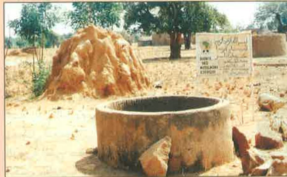
★ المنطقة بحاجة إلى آبار حيث جفت هذه البئر مؤخراً
