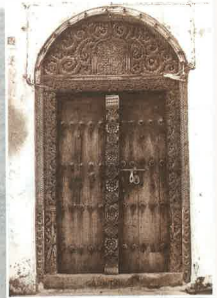
★ هذا الباب الذي يرجع تاريخه إلى العام الهجري ١٣١٢، يتميز بنقش الكتابة التي توضح أنه مبني مسجد يحتوي على نماذج غير مألوفة في مساجد مدينة الحجر
