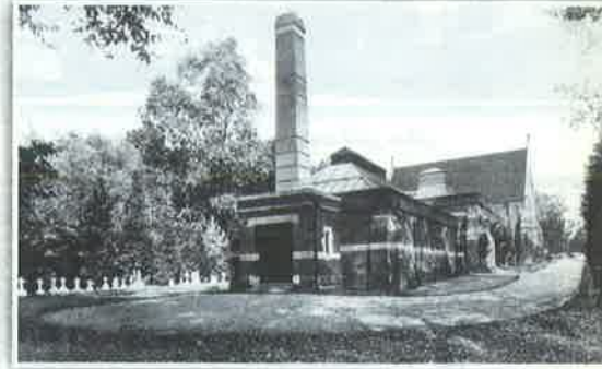
★ مبنى محرقة الجثث في وكنج
