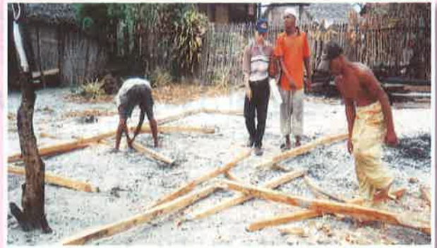
البدء في إعادة بناء البيوت
