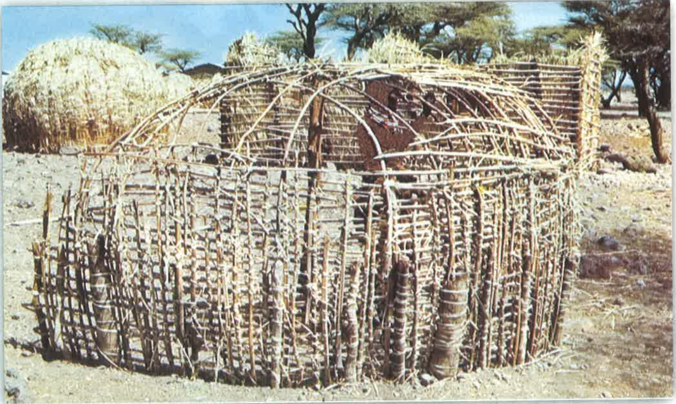
كوخ في طور البناء
