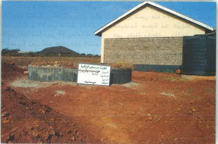
بسبب شح المياه في المنطقة أقامت مسلمي إفريقيا هذا الخزان
