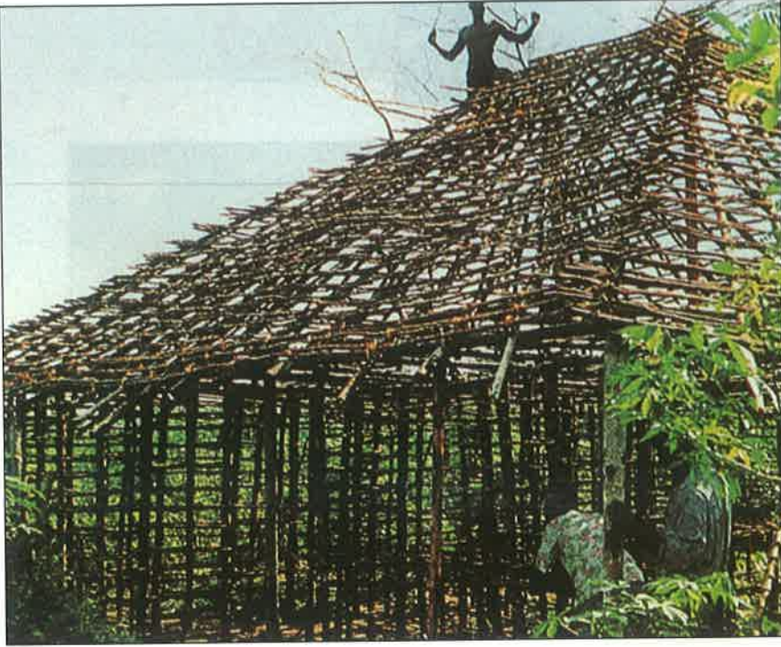
• الهيكل الخشبي الداخلي للمنزل التقليدي في موييز
